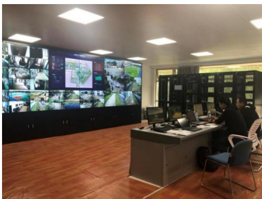
图 3.11 校园综合安防监控室
